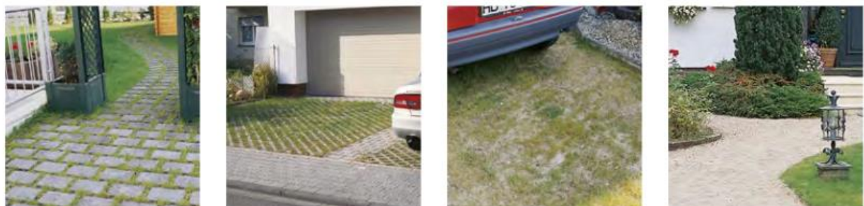
Abb. 11: Versickerungsfähige Beläge (Quelle: Regenwasserversickerung – Gestaltung von Wegen und Plätzen Praxisratgeber für den Grundstückseigentümer (Bayerisches Landesamt für Umwelt))
