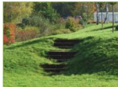
Bild 4.33: Offene Kaskadenrinne zur Ableitung des Regenwassers in eine Mulde zur Retention und Versickerung (PRE-Park, Kaiserslautern, D)
