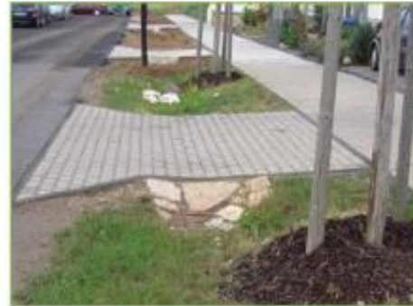
Bild 4.31: Grundstückszufahrt über straßengeleitenden Graben (MUF, 2000)
