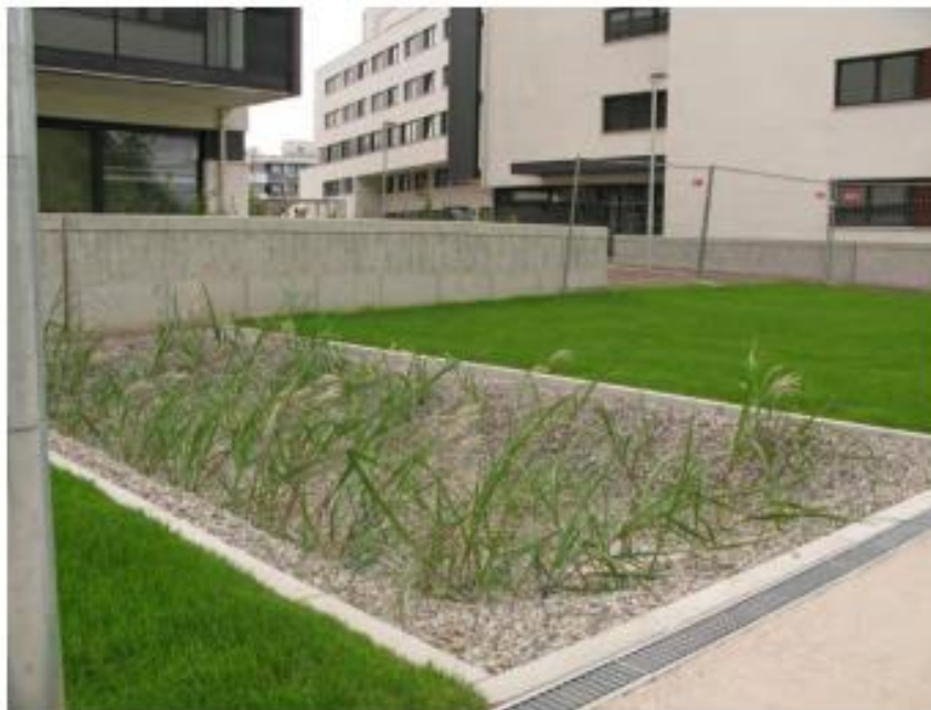
Abb. 20: Mit Gräsern bepflanztes Mulden-Rigole (Foto: Büro Grimm, Quelle: Integratives Regenwassermanagement: Beispielsammlung (Magistrat der Stadt Wien, Wiener Umweltschutzabteilung))
