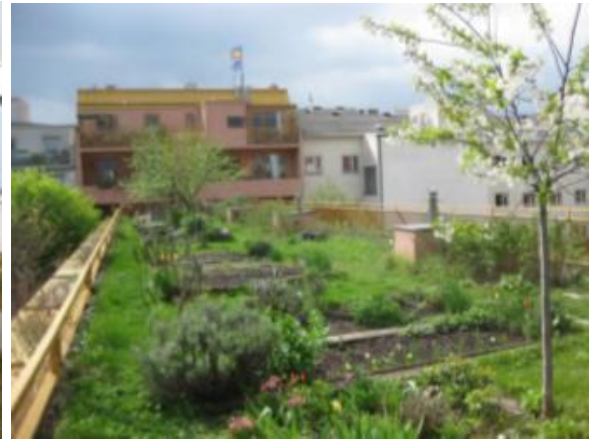
Abb. 7: Intensiv begrünte Dachfläche mit Nutzbeeten (Foto: Büro Grimm, Quelle: Integratives Regenwassermanagement: Beispielsammlung (Magistrat der Stadt Wien, Wiener Umweltschutzabteilung))
