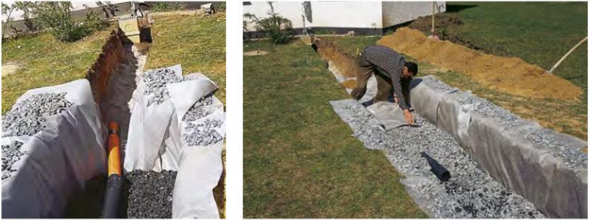
Abb. 17: Anschluss des Versickerungsrohrs (Abb. links) und Kies und Schotter mit Vlies abdecken (Abb. Rechts), Quelle: Regenwasserversickerung – Gestaltung von Wegen und Plätzen Praxisratgeber für den Grundstückseigentümer (Bayerisches Landesamt für Umwelt)
